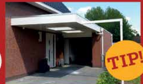
EIGEN LIJN CARPORTS
