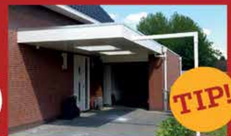
EIGEN LIJN CARPORTS
