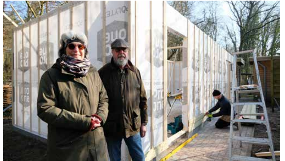
Jaco van Gils en Linda Glimmerveen tonen het multifunctioneel gebouw in aanbouw (foto Jan Johan ten Have)
